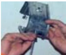
Montage des Befestigungssets als Halterung des Hermannkanals an der Hermannschelle
