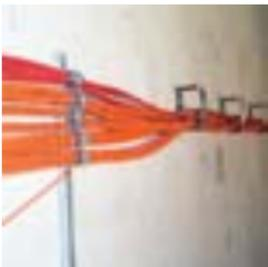
Bei der horizontalen Kabelbefestigung müssen die Schellen gegen Abrutschen im Brandfall gesichert werden (z.B. mit einer Gleitmutter).
