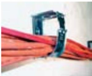
Nachdem die Kabel verlegt sind, wird die Hermanschnelle mittels der integrierten Klappmechanik verschlossen. Eine Nachbelegung ist jederzeit ohne Aufwand möglich. Der Befestigungsabstand für den Funktionserhalt der Hermanschnelle beträgt bis zu 800 mm je nach Kabelbauart.
