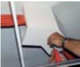
Verschrauben des Hermannkanals mit der Hermanschelle
