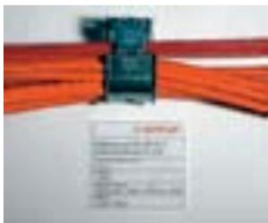
Die Kabelanlage muss dauerhaft mit einem Kennzeichnungsschild versehen werden.
