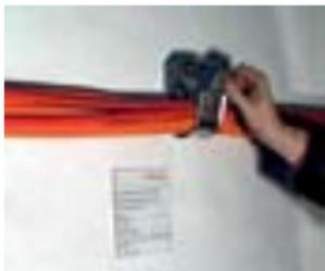
Durch die große Öffnung werden die Kabel problemlos in die Hermanschnelle eingelegt. Hierbei ist zu beachten, dass die Kabel mit hohem Gewicht unter den Kabeln mit niedrigerem Gewicht liegen.
