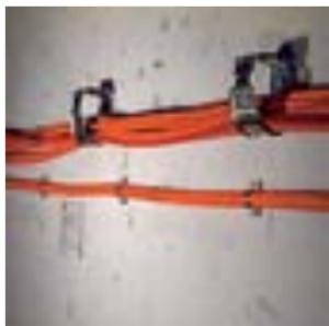
Der Befestigungsabstand für den Funktionserhalt der SAS-Schellen beträgt bis zu 1200 mm, je nach Kabelbauart.
